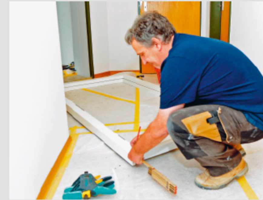
In diesem Fall ist der Umbaurahmen wenige Millimeter zu lang. Vor Ort kürzt unser Monteur den Rahmen auf das korrekte Mass.
