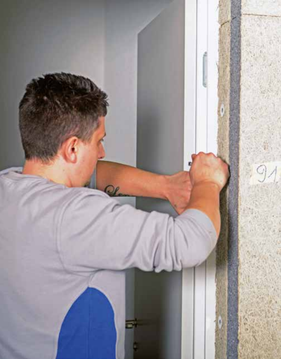
Für die Montage und Justierung dieses Funktionsdoppels ist nur ein Monteur notwendig.
